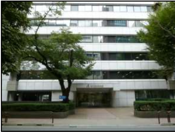
労働金庫会館
